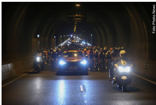
Doortocht in de Oostbuis van de Westerscheldetunnel, 6,6 km lang, van Terneuzen in Zeeuws-Vlaanderen naar Ellewoutsdijk op Zuid-Beveland.
